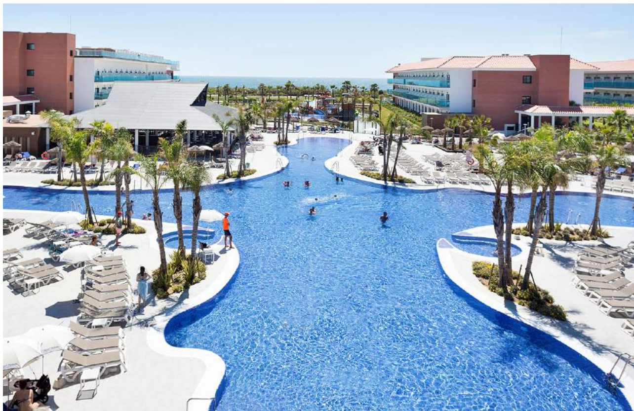
Best Hotels ha apostado por CHOVAFOAM para las cubiertas
