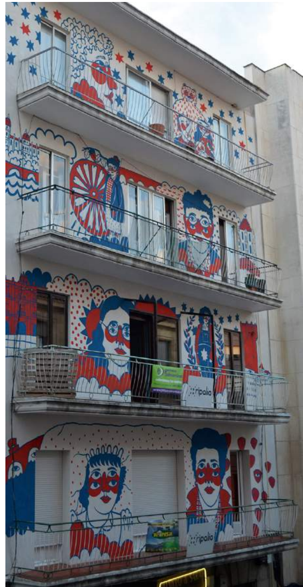
La fachada se rehabilitó mejorando el aislamiento
