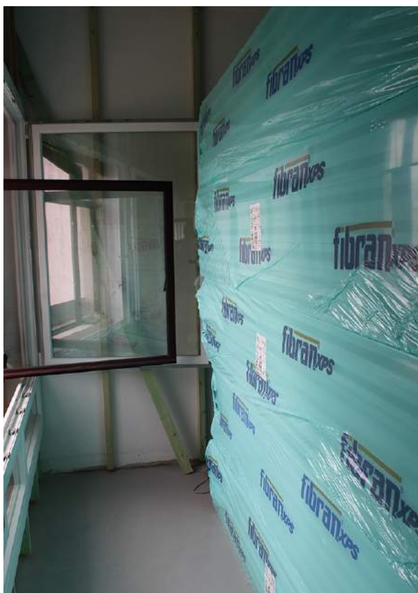
El material instalado fue se instaló FIBRANxps ETICS GF
