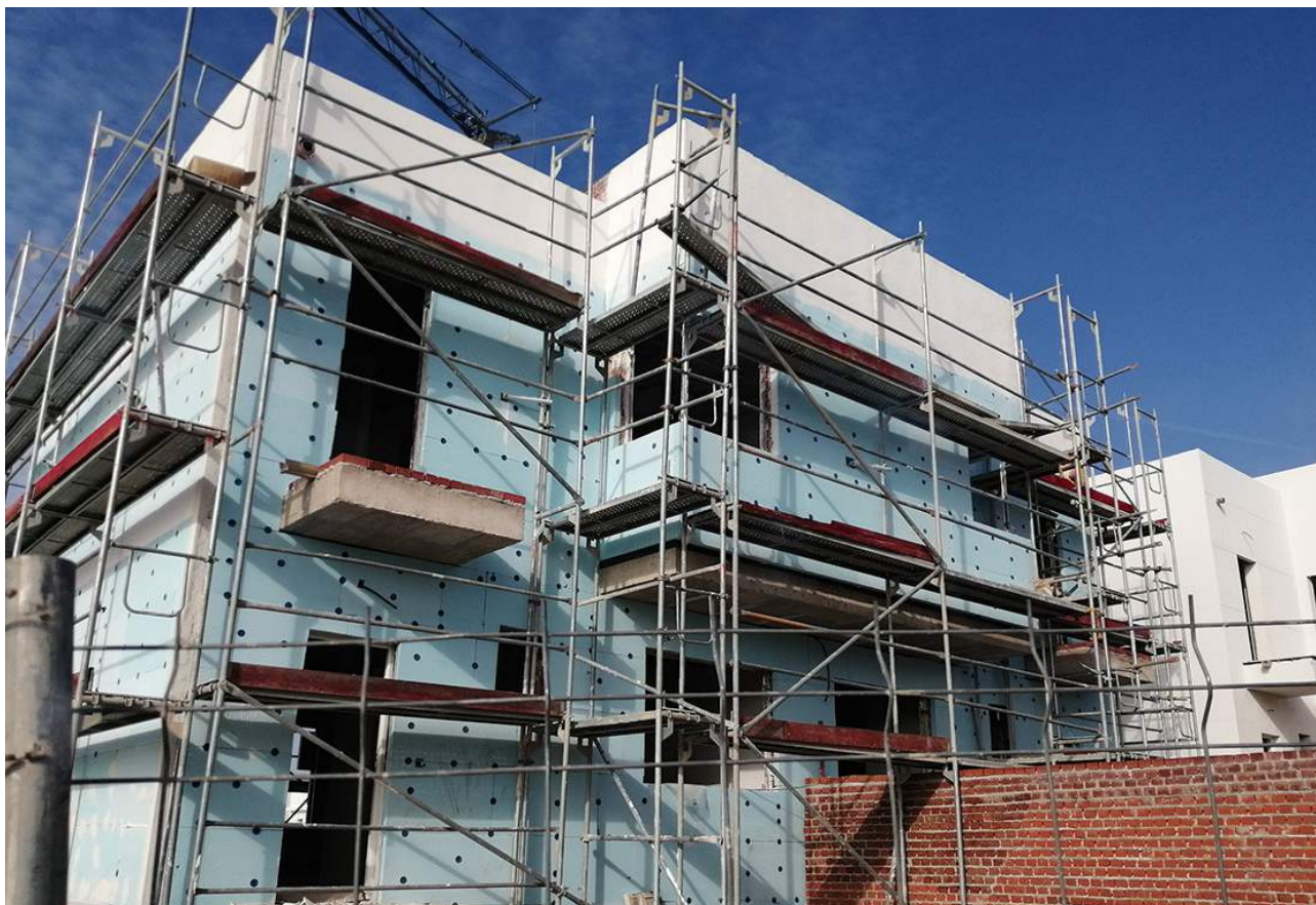
El acabado de la fachada se ha realizado con Revestidan SATE Acrílico
