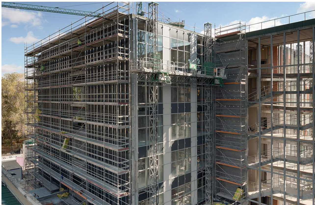
Las obras de construcción finalizaron en 2018
