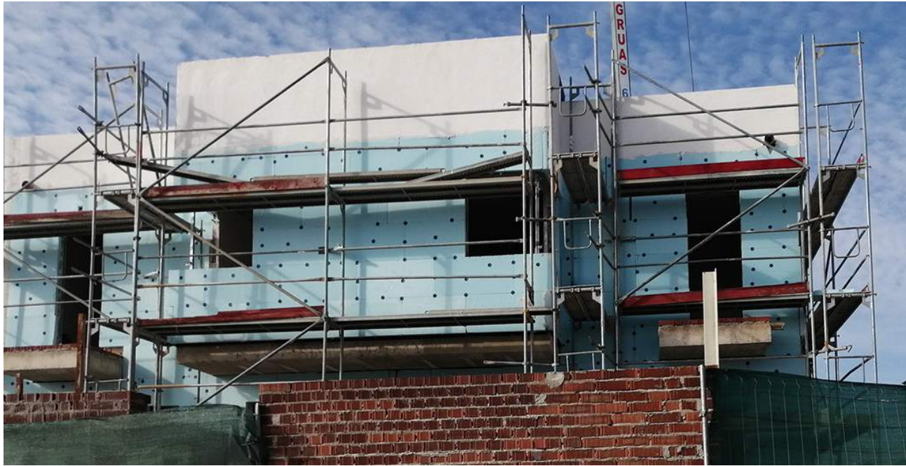
Destacan los aislamientos térmicos y acústicos entre plantas
