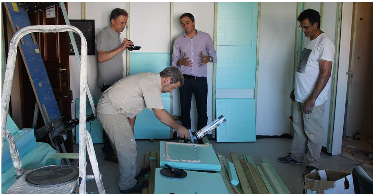
Se empleó XPS para mejorar el aislamiento térmico del inmueble
