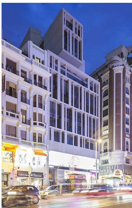
Edificio Gran Vía, 48, adquirido por Greystar
