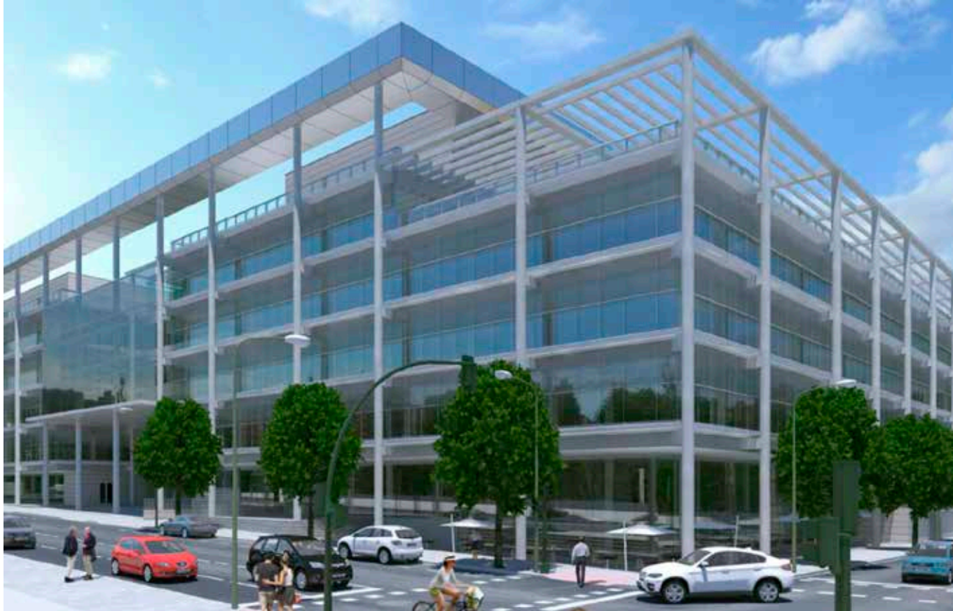
Edificio OM \infty , actualmente en construcción, propiedad de Torre Rioja
