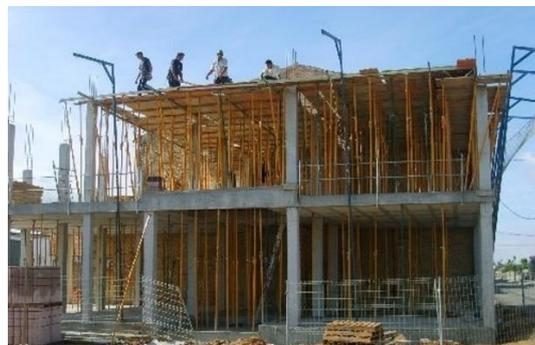
Imágenes.- Estructura prefabricada de hormigón frente a una estructura resuelta in situ. Eficacia en la construcción.
