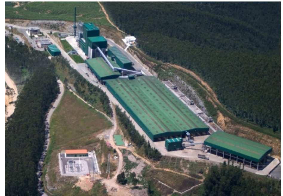
Planta Integral de tratamiento de residuos. Meruelo
