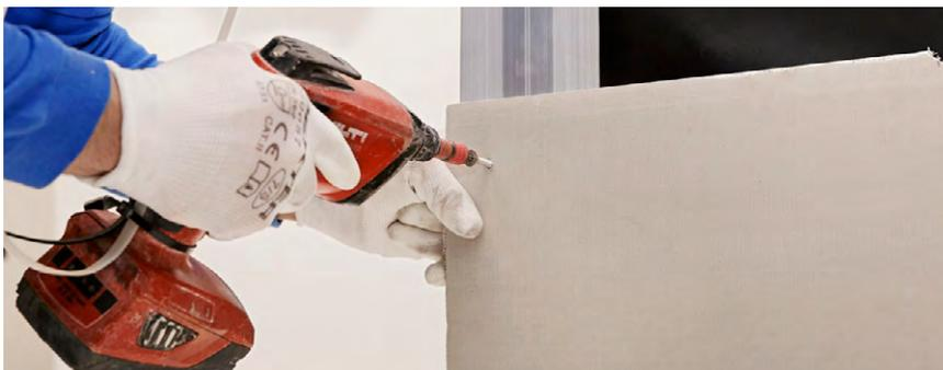
Montar la perfilera de acero galvanizado de ancho 100 mm y atornillar la placa Knauf Aquapanel Outdoor con la tornillería Aquapanel Maxi. La placa es pasante y continua por delante de frentes de forjado y pilares.
