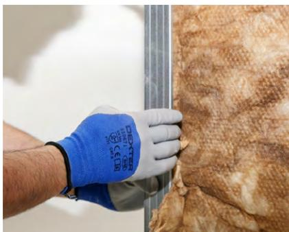
Rellenar el perfil de 100 mm con la lana mineral Ultracoustic O35 en 100 mm y atornillar la placa de yeso a los montantes de Aquapanel.
