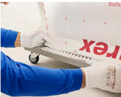
Colocación de la membrana de estanqueidad Majrex y las cintas Sicrall y sobre la placa de yeso intermedia.
