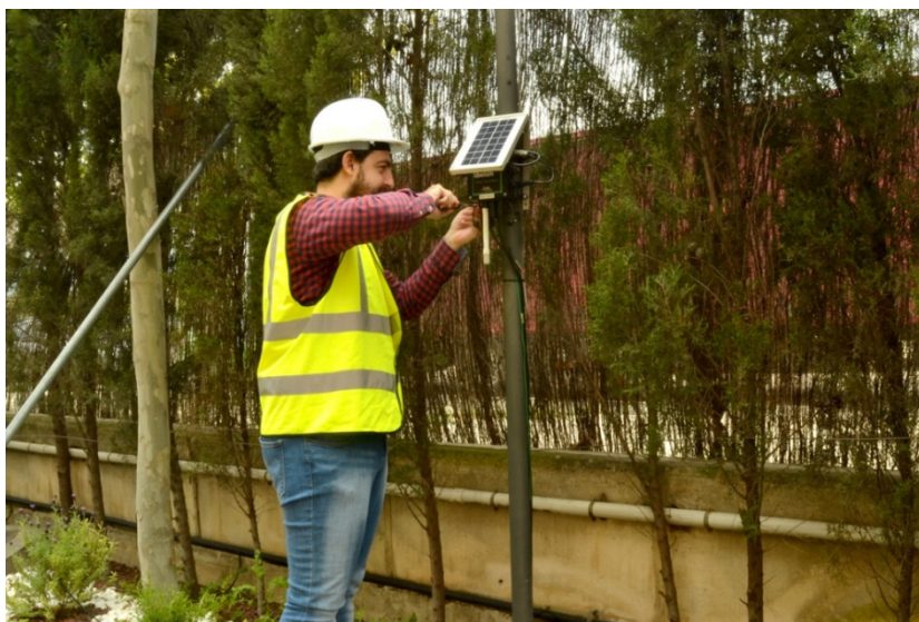
Figura 2. Técnico de Libellium durante la instalación de los nodos.
