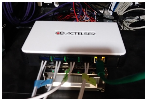
Figura 4. Switch instalado.
