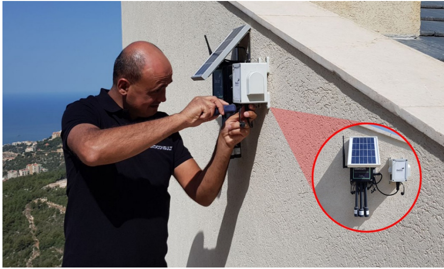
Figura 5. Instalación de los nodos en BeitMisk.
